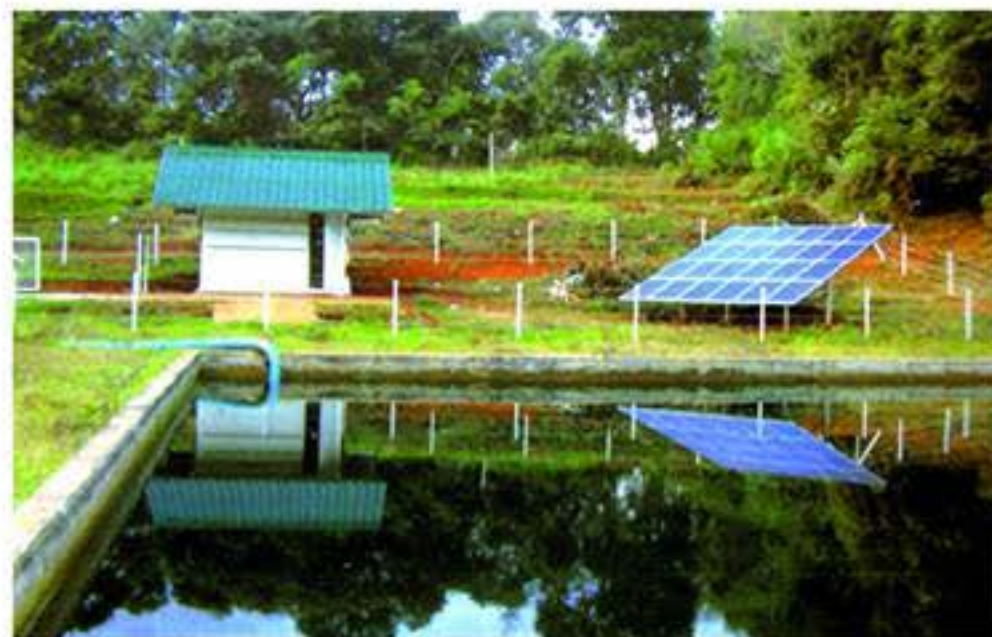
ระบบสูบน้ำพลังงานแสงอาทิตย์ สถานีพัฒนาการเกษตรที่สูงตามพระราชดำริ บ้านขุนแตะ อำเภอจอมทอง จังหวัดเชียงใหม่
